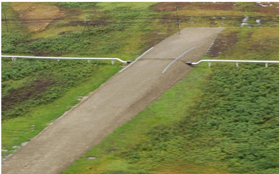
Рисунок 1 – Переход через нефтепровод ЦПС «Южное-Хыльчую» – БРП «Варандей»
