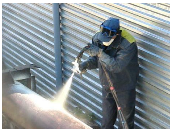
Рисунок 4 – Теплоизоляция трубопроводов с использованием краски
