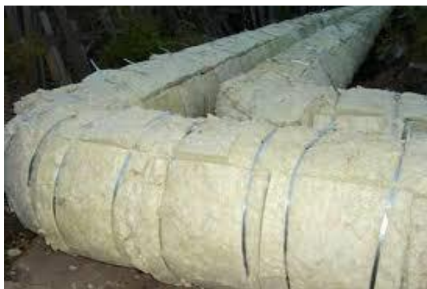
Рисунок 3 – Теплоизоляция трубопроводов с использованием стекловаты
