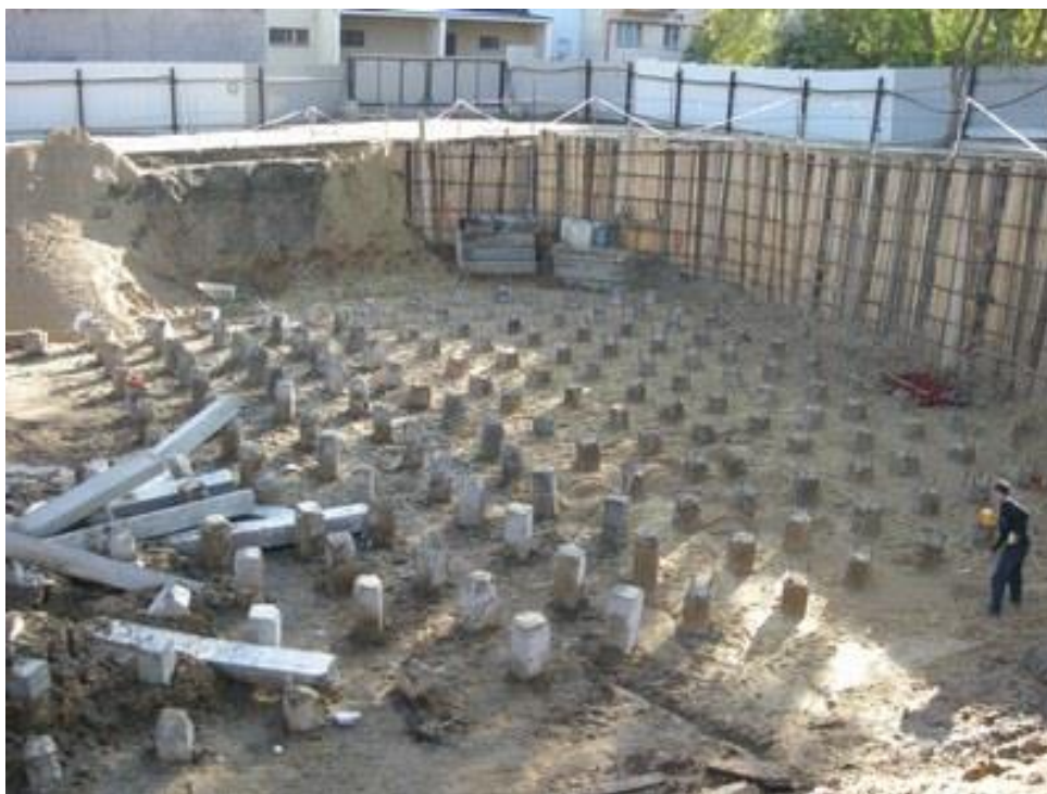
Рисунок 3 – Строительство сооружения на свайном фундаменте
